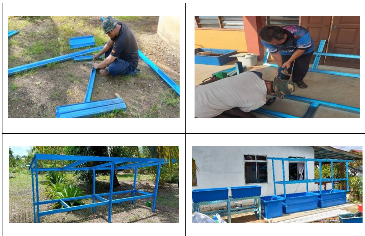
Rajah 2: Kerja Pemasangan Ezee DIY Aquaponics Design
